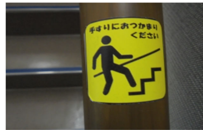
【鹿島】ヒヤリハット報告内容の対策事例③ 総合管理棟階段手すりへの“手すり持ち”表示
